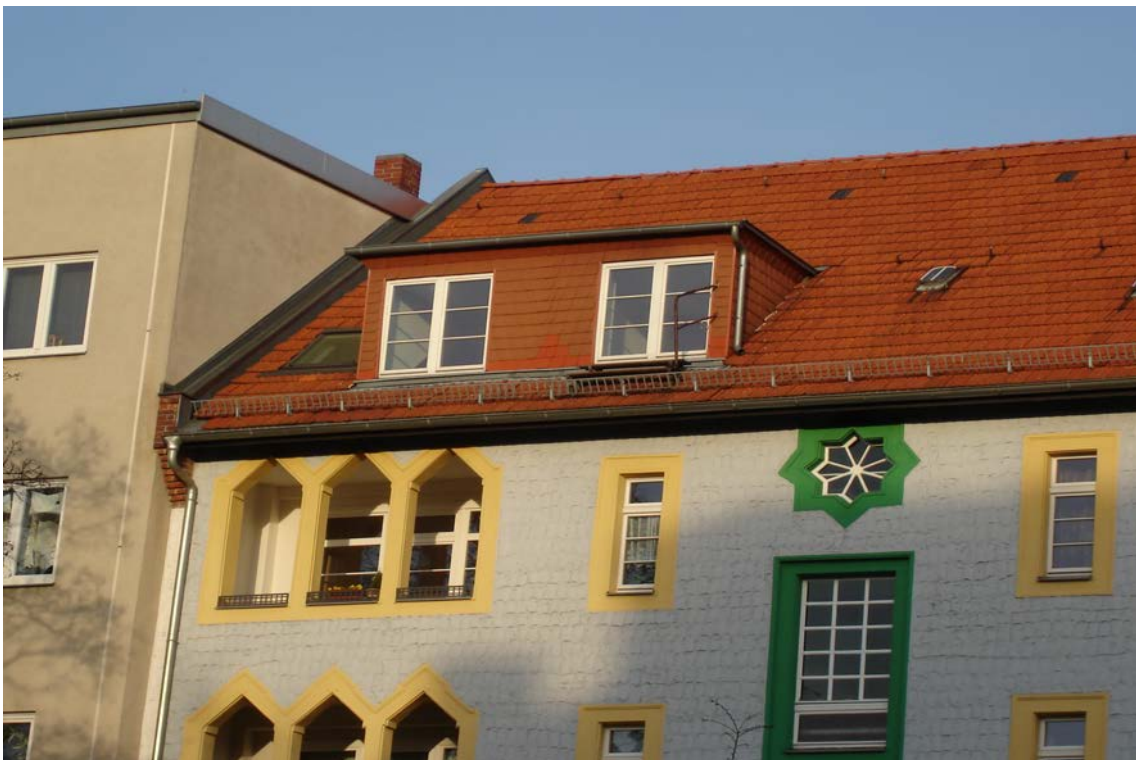
Gaube der quasi neu ausgebauten DG-Wohnung Bismarckstr. 47c
