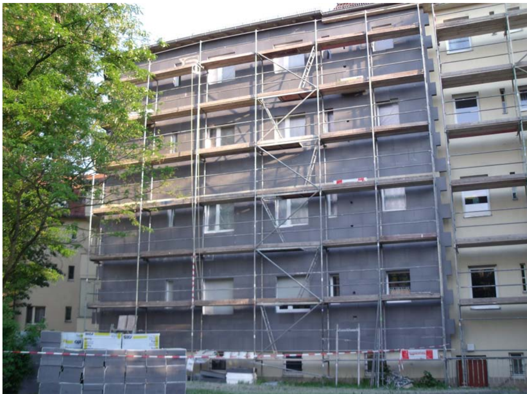
Wärmedämmmaßnahmen in der Wohnanlage 4: Blumenweg 16a, 17
